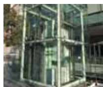
機械室レスエレベーター
